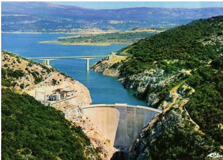
Retenue de Sainte-Croix
